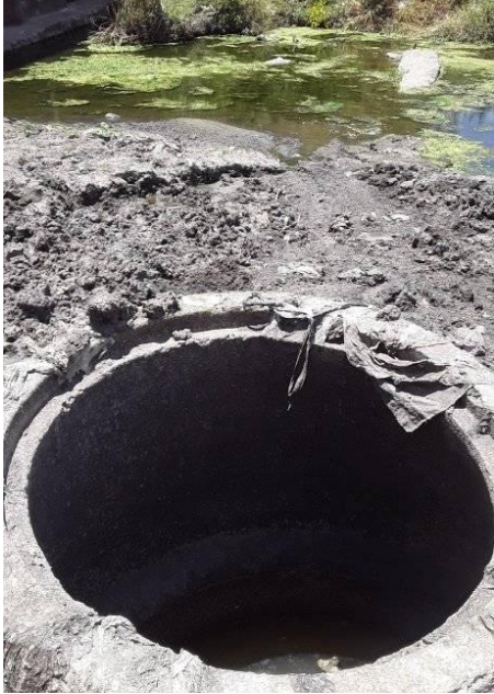
Figura 1. Vertido de agua residuales.
